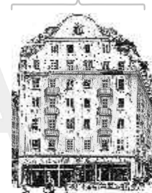
Pension Central (Arh. M. Hubert, 1928) Actual Hotel Timișoara
